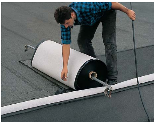
Die NOVOPROOF® Dachdichtungsbahn DA-S ist auf der Unterseite mit einer robusten Dickvlieskaschierung ausgestattet.
