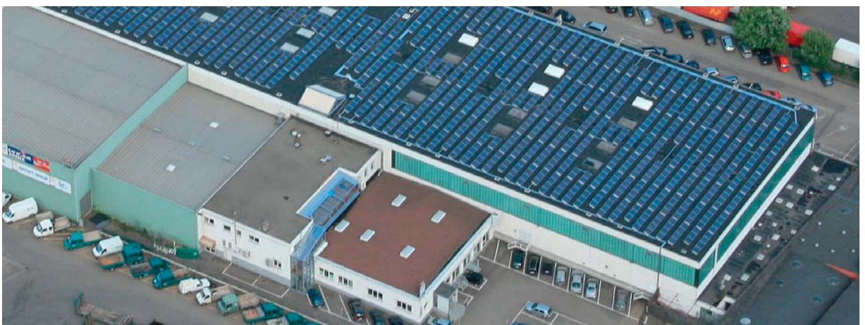
Solaranlage mit 319 kWp Gesamtleistung auf 10.000 m 2 EPDM-Dachabdichtung NOVOPROOF® DA-K.
