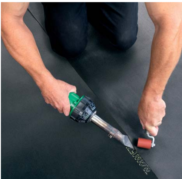
Der Heißluftföhn bietet sich für An- und Abschlüsse und die Integration von Formteilen an.
