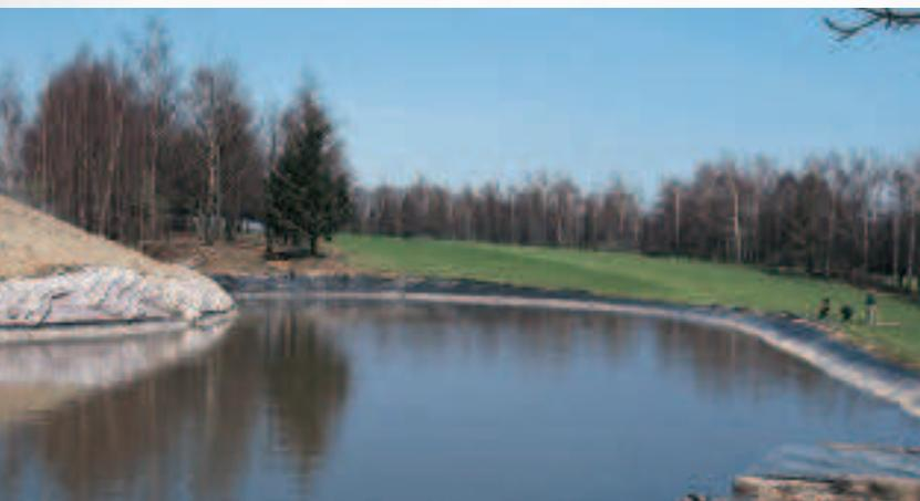
Die freiliegenden Planenränder der Wasserreservoirs auf Golfplätzen halten selbst stärkstem Ballbeschuss stand.
