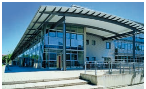
Fassadenabdichtung an der Fachhochschule Rosenheim.
