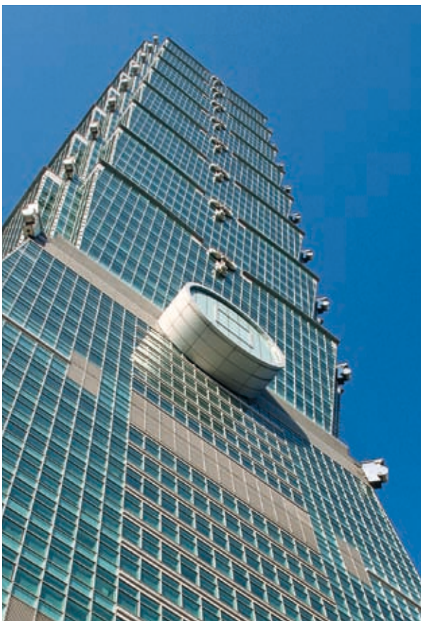
5.000 qm Fassadenabdichtung am TOWER 101, Taipeh.
