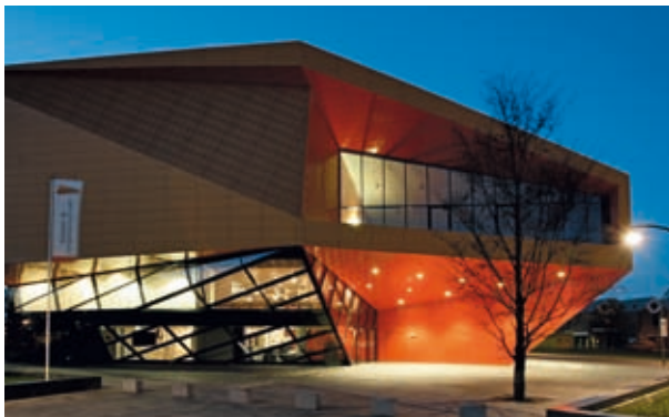
Fassadenabdichtung Agora-Theater, Leylstad, Niederlande.
