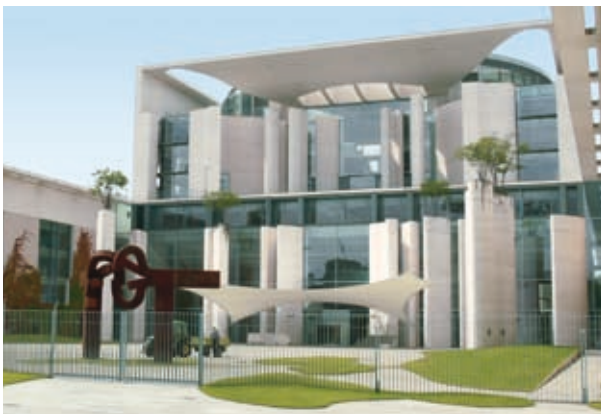
Einsatz von Fassadendichtstreifen am Bundeskanzleramt, Berlin.
