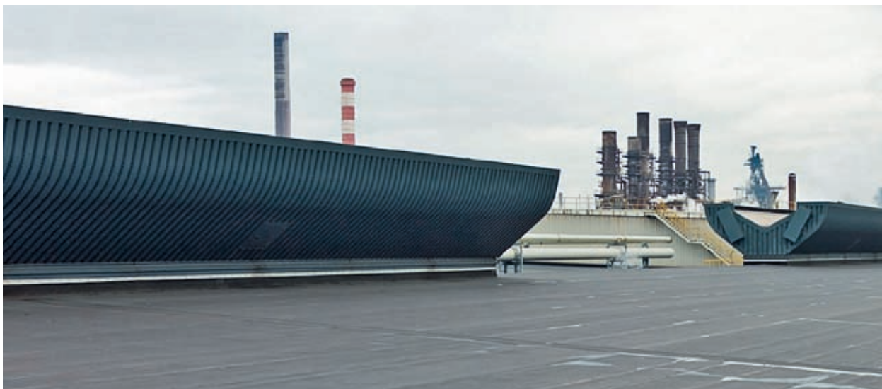
EPDM-Abdichtung auf dem Walzwerk „Dillinger Hütte“.
