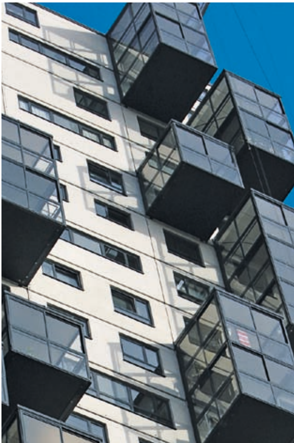
Hochhaus De Stadsheer Tilburg, Holland.
